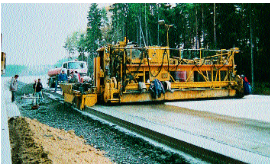
Bild 11: Gleitschalungsfertiger als Trägergerät für eine Anbauschalung zur Herstellung einer Entwässerungsrinne in Gleitschalungstechnik
