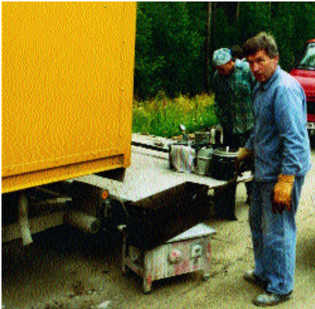
Bild 5: Neben den einschlägigen Betonprüfungen der ZTV Beton wurden von den Vertragsparteien zusätzliche Prüfungen durchgeführt, z. B. Prüfung der Biegezugfestigkeit an Betonbalken. Das Bild zeigt die Herstellung von Betonbalken direkt an der Einbaustelle.
