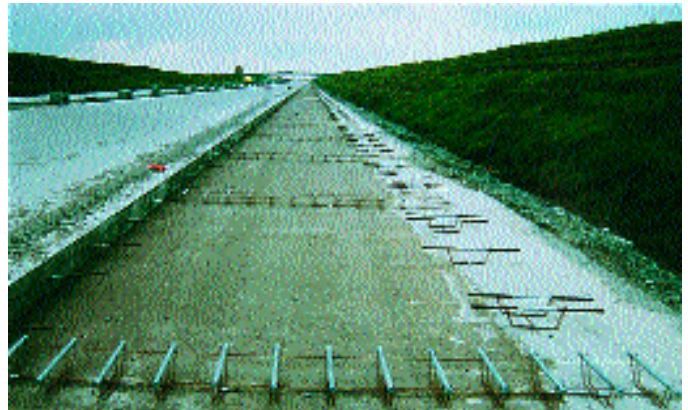
Bild 10: Für einlagig hergestellte zusätzliche Fahrstreifen wurden die Dübel für die Querscheinfugen sowie die Anker für die Längsscheinfugen vor dem Betonieren auf Körben verlegt.
