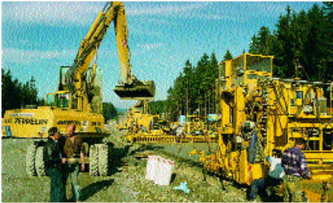
Bild 9: Der Oberbeton wurde mit einem Vorderbeschicker über den Unterbetonfertiger hinweg und/oder mit einem Bagger von der Seite auf dem verdichteten Unterbeton, vor den Oberbetonfertiger vorgelegt.
