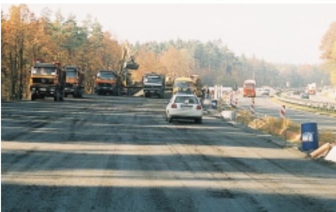
Bild 10: Der Transport des Ober- und Unterbetons von den Mischanlagen zum Einbauzug erfolgt in Lkw mit Stahlmulden, die entsprechend dem Transport von Ober- bzw. Unterbeton deutlich gekennzeichnet sind.
