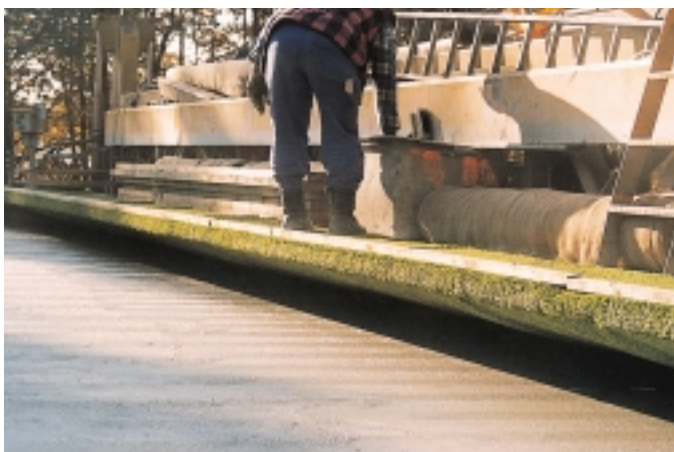
Bild 16: Wird anstelle des Jutetuchs ein Kunstrasen in Längsrichtung über die frische Betondeckenoberfläche geschleppt, entsteht ebenfalls eine Oberfläche mit einer dauerhaft hohen Griffigkeit und einer geringen Geräusentwicklung.
