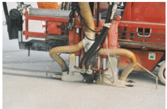
Bild 17: Fugenschneidgeräte mit Anlagen zum Absaugen des Schneid-schlammes direkt am Sägeblatt
