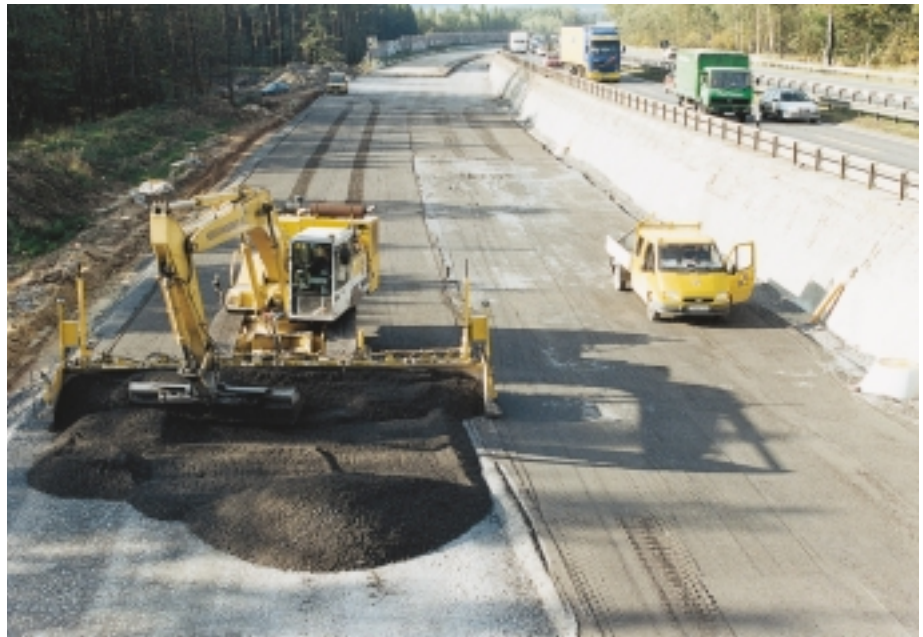
Bild 7: Einbau der Tragschicht ohne Bindemittel (ToB) mit einem H+W-Multitalent
