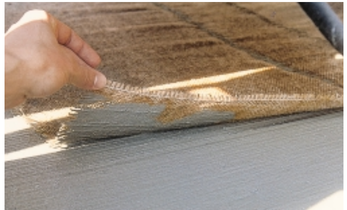
Bild 15: Wird über die frische Betondeckenoberfläche in Längsrichtung ein Jutetuch nachgezogen, entsteht eine dauerhaft griffige und geräuscharme Oberflächentextur.
