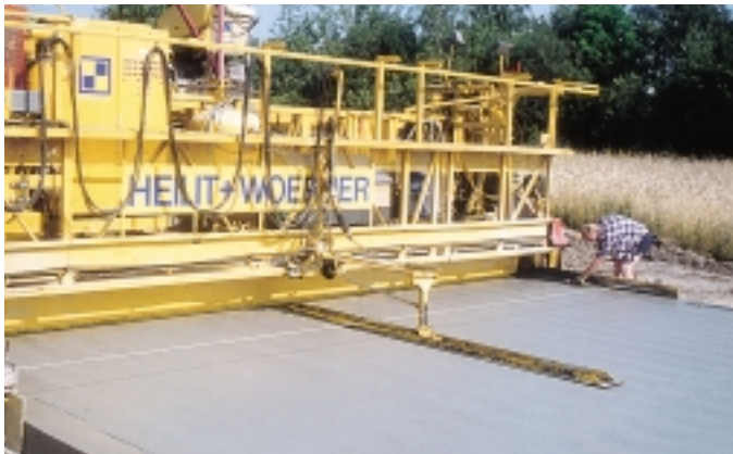
Bild 14: Längsglätter („Smoother“) am Oberbetonfertiger zum Glätten der frischen Betondeckenoberfläche in Längsrichtung
