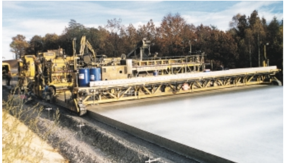
Bild 12: Betondecken-Einbauzug zur Herstellung von Verkehrsflächen aus Beton in zweischichtiger Bauweise. Blick auf die fertige Betondeckenoberfläche, im Vordergrund die Arbeitsbühne, von der aus die Oberfläche durch Nachschleppen eines Jutetuchs zur Herstellung einer Oberfläche mit dauerhaft hoher Griffigkeit und geringer Geräusentwicklung strukturiert und das Nachbehandlungsmittel aufgesprüht wird.
