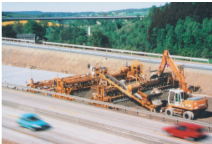
Bild 5: Für den Einbau einer Betondecke mit einem „dünnen Oberbeton“ sind die herkömmlichen Betondeckenfertiger gegebenenfalls zu modifizieren
