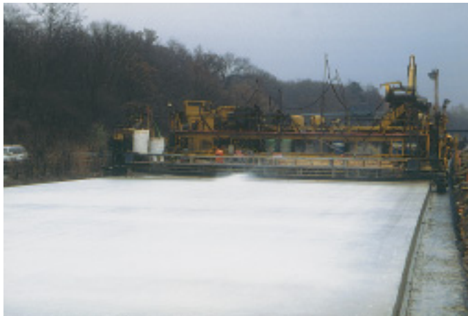
Bild 3: Flächendeckendes Aufsprühen eines flüssigen Beton-Nachbehandlungsmittels auf die frische Betonoberfläche
