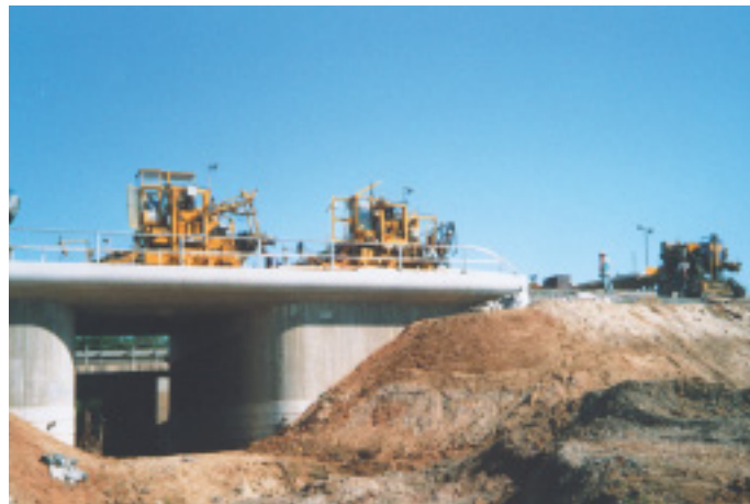
Bild 7: Zweischichtiger Betondeckeneinbau mit Gleitschalungs- fertigern auf einer kurzen Brücke ohne Übergangskon- struktion
