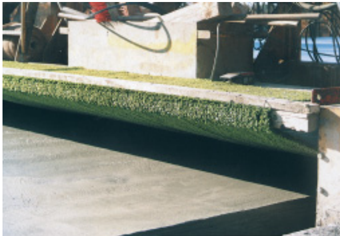
Bild 2: Strukturierung einer frischen Betondeckenoberfläche durch Nachziehen eines Kunstrasens in Längsrichtung
