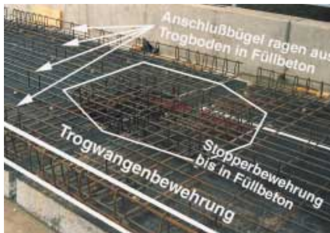
Bild 13: Feste Fahrbahn System Rheda auf langen Brücken: Aus der Trogplatte ragen Bewehrung im Bereich der Stopper und Anschlußbügel in den Füllbeton
