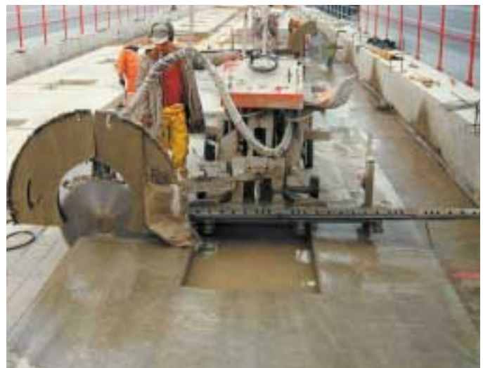
Bild 9: Feste Fahrbahn System Rheda auf langen Brücken: Ausschneiden der Querfugen in der betonierten Höckerplatte
