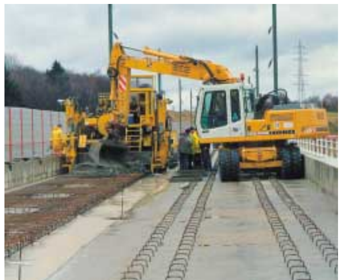
Bild 10: Feste Fahrbahn System Rheda auf langen Brücken: Betonieren der Höckerplatte als durchgehende Platte mit einem modifizierten WH-Gleitschalungsfertiger
