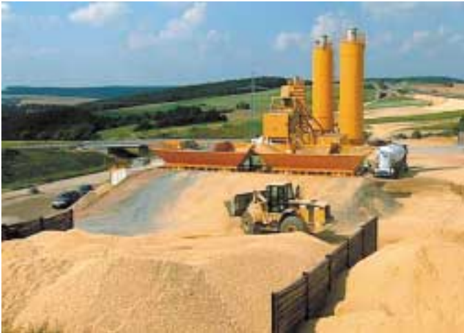
Bild 14: Für die Herstellung der Feste Fahrbahn im Zuge der Neubaustrecke von Frankfurt nach Köln wurden Baustellenmischanlagen aufgebaut, wie sie vom Betonstraßenbau bekannt sind, hier: Chargenmischanlage
