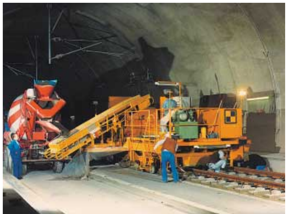
Bild 3: Sengebergertunnel 1989 – zum ersten Mal mechanisierte Herstellung einer Festen Fahrbahn (System Rheda mit Trog), hier: Einbringen des Füllbetons mit einem WH-Taktfertiger
