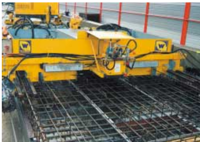
Bild 12: Feste Fahrbahn System Rheda auf langen Brücken: Von Hydraulikwinden gezogene WH-Gleitschalungseinheit zum Betonieren des Betontrogs
