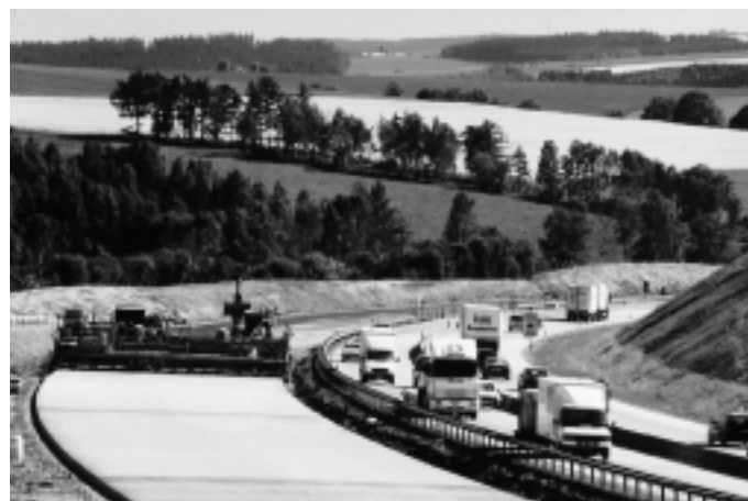
1: Herstellung einer Fahrbahndecke aus Beton in Gleitschalungstechnik für eine Autobahn der Bauklasse SV
