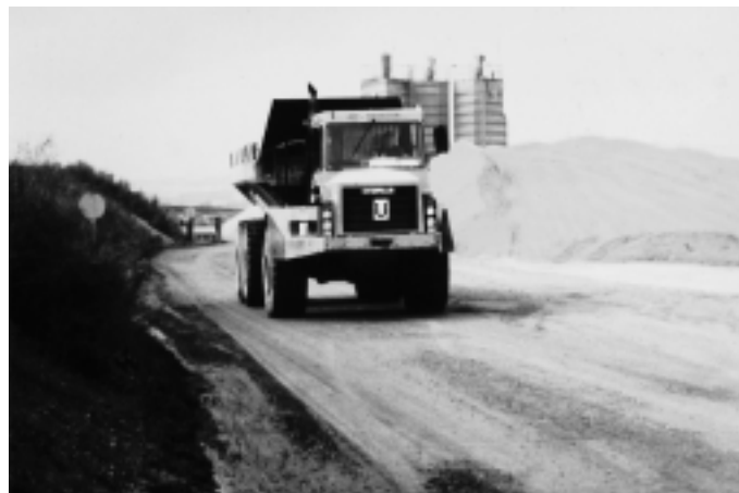
9: Bei zweischichtigem Betoneinbau müssen die Transportfahrzeuge für den Unter- bzw. Oberbeton deutlich und dauerhaft gekennzeichnet sein, um Verwechslungen der Betonarten auszuschließen
