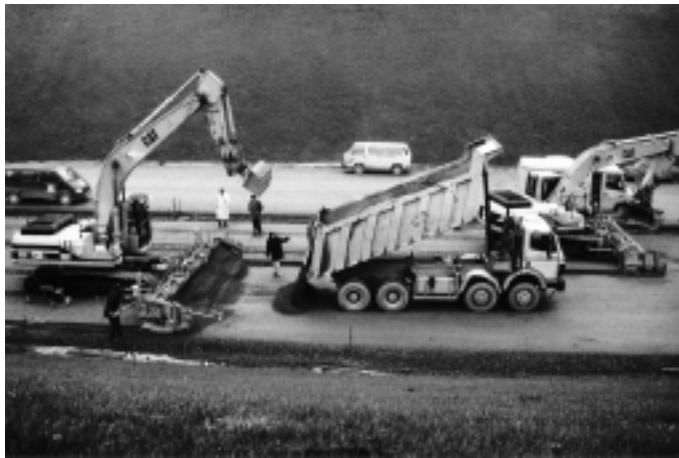
8: Eine anforderungsgerechte Tragschicht unter der Betondecke ist Grundvoraussetzung für eine dauerhafte Verkehrsfläche aus Beton. Einbau einer hydraulisch gebundenen Tragschicht mit zwei gestaffelt fahrenden H+W-Multitalenten
