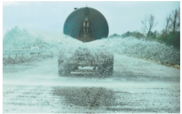
20: Vor dem Betondeckeneinbau ist die ToB vorzunässen
