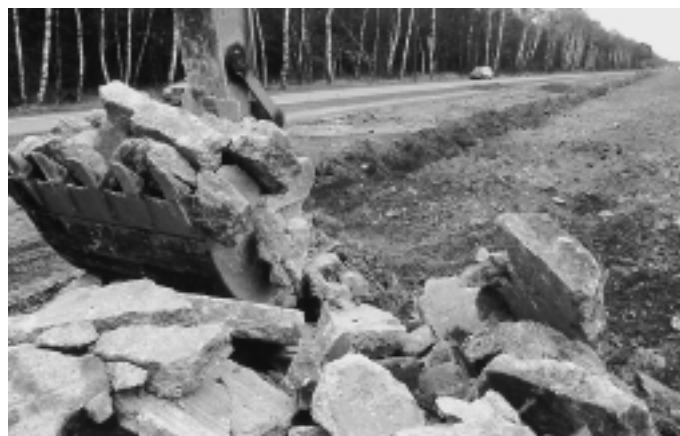
6: Die Sorgfalt des Baggerführers und die Art des Baggerlöffels sind bei der Optimierung des Ladevorgangs hinsichtlich Leistung und Qualität des aufgenommenen Materials zu beachten
