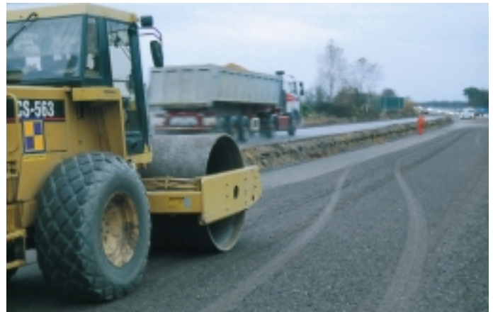
10: Die Verdichtung einer ToB kann mit einem Walzenzug erfolgen. Vor dem Betondeckeneinbau sollen unvermeidbare Verdrückungen und lose Teile der ToB z. B. ebenfalls durch Walzen nachverdichtet werden
